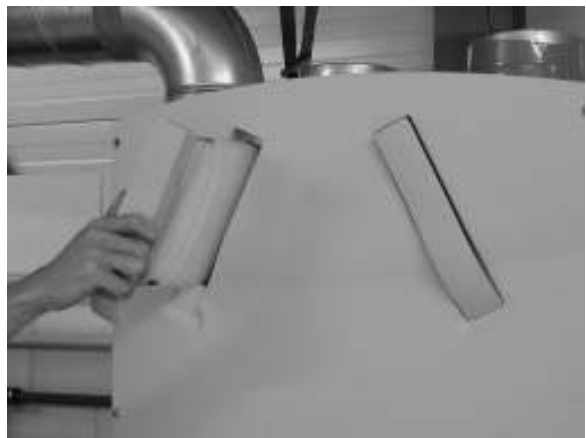
Fig. 2 Het uitnemen van de stoffilters
